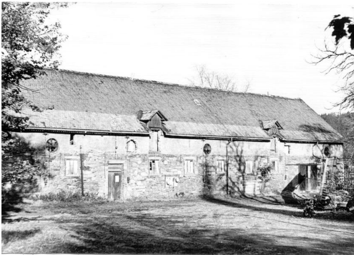
ehem. Kuhstall Hofseite
