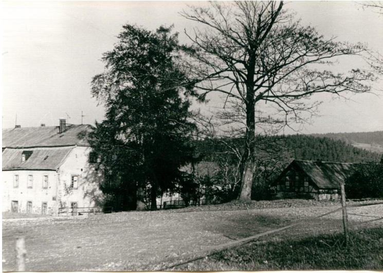
Gesamtansicht Schönheider Straße
